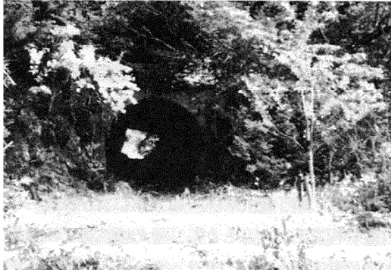
1 A地点トンネル入り口
